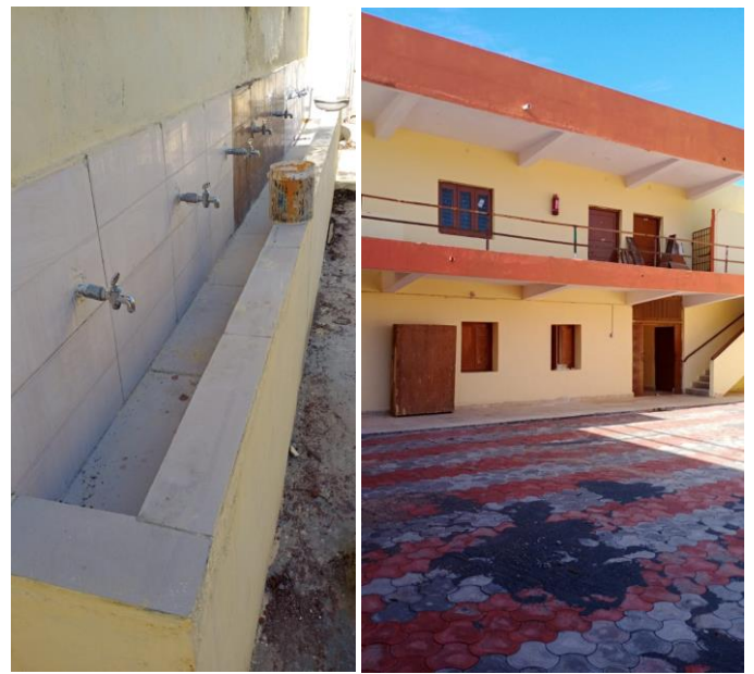
Renovierung der Internatsgebäude in Sihor (Indien)
